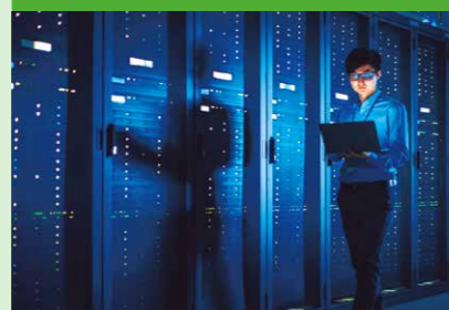
クラウド・ネットワーク&データセンター・IT運用
