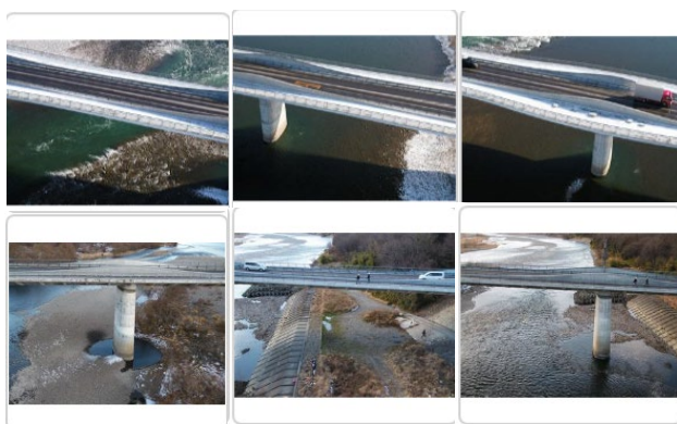
橋梁を撮影した写真群
