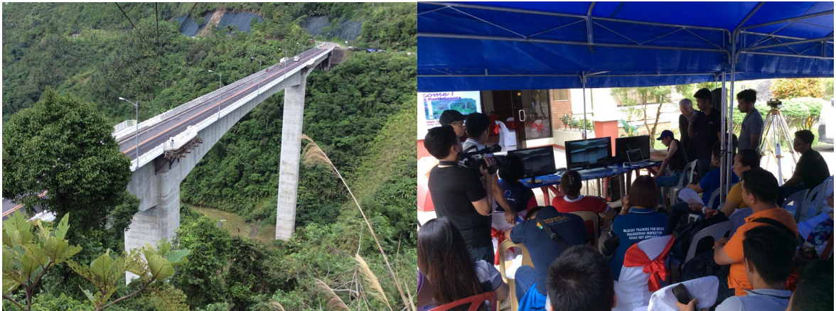
実証実験を行った「アガスアガス橋」(左)と実証実験の様子(右)
