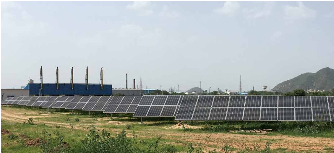
図1 実証開始した太陽光発電を活用したマイクログリッドシステム
