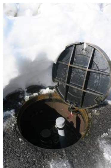
マンホールに発信機を取り付ける様子
