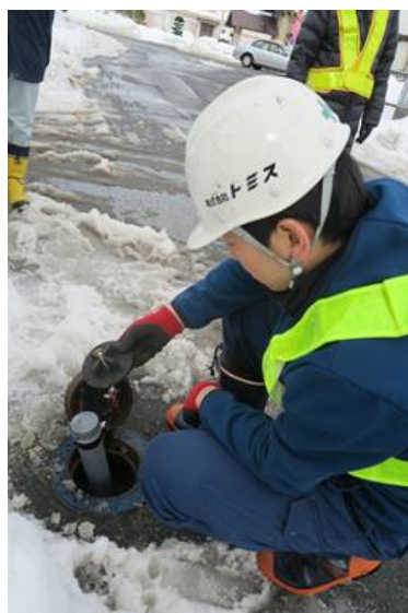
マンホールに発信機を取り付ける様子
