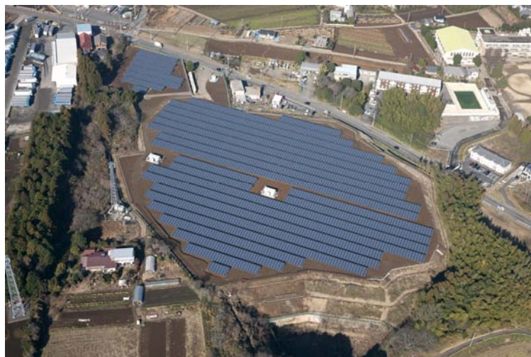
完成した日本国土開発の太陽光発電所「アンビックスソーラー富里」
