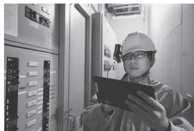
写真1 点検作業の光景
