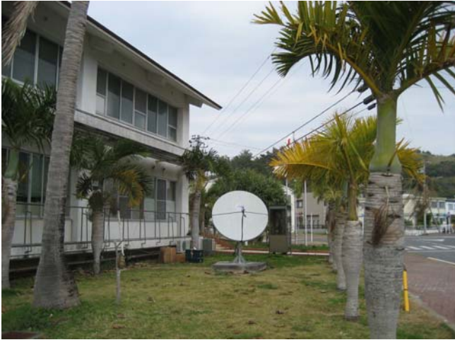
▲小笠原村役場に設置した衛星用アンテナ
